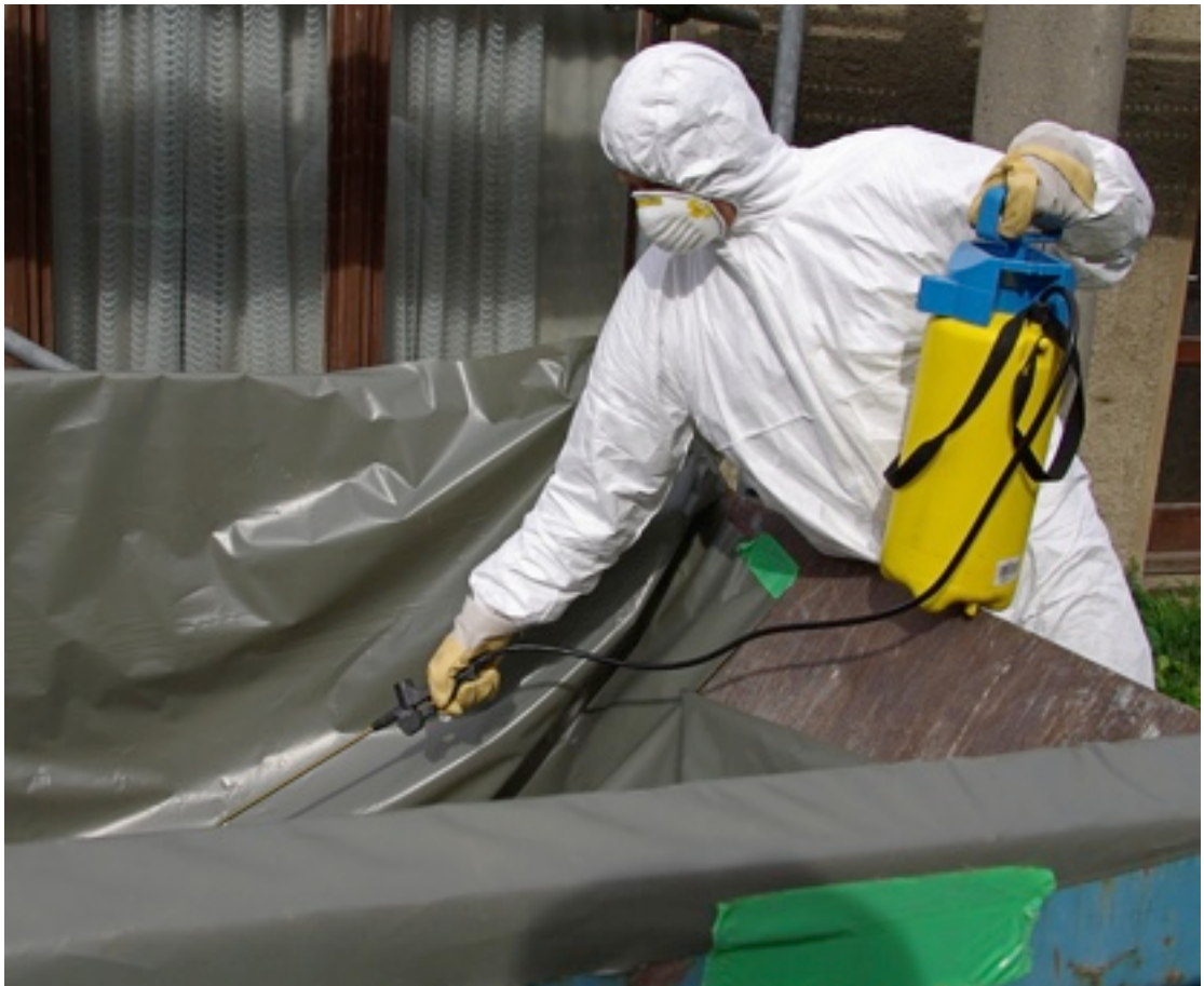
Photo libre de droit - Opération de désamiantage
